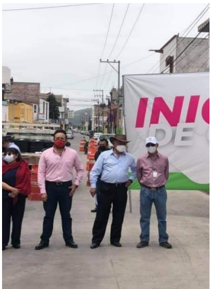
Inicio de obra en la calle Luis M. Ponce, colonia Centro.
