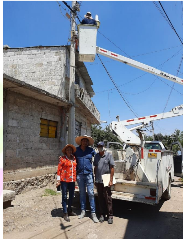
Recorrido para conocer las condiciones de las luminarias para su mantenimiento.
