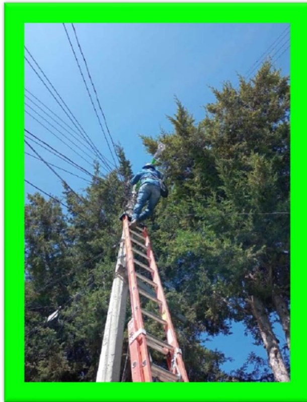
Se llevo a cabo cambio de nuevas luminarias
