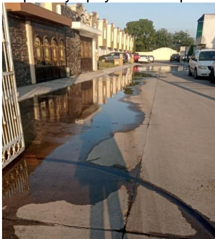
Reporte y apoyo en la reparación de fuga de agua en la col. Los Sabinos.
